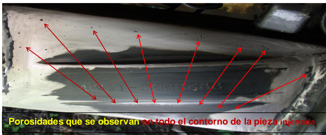
Figura 112. Cordones de soldadura del injerto que han sido esmerilados
