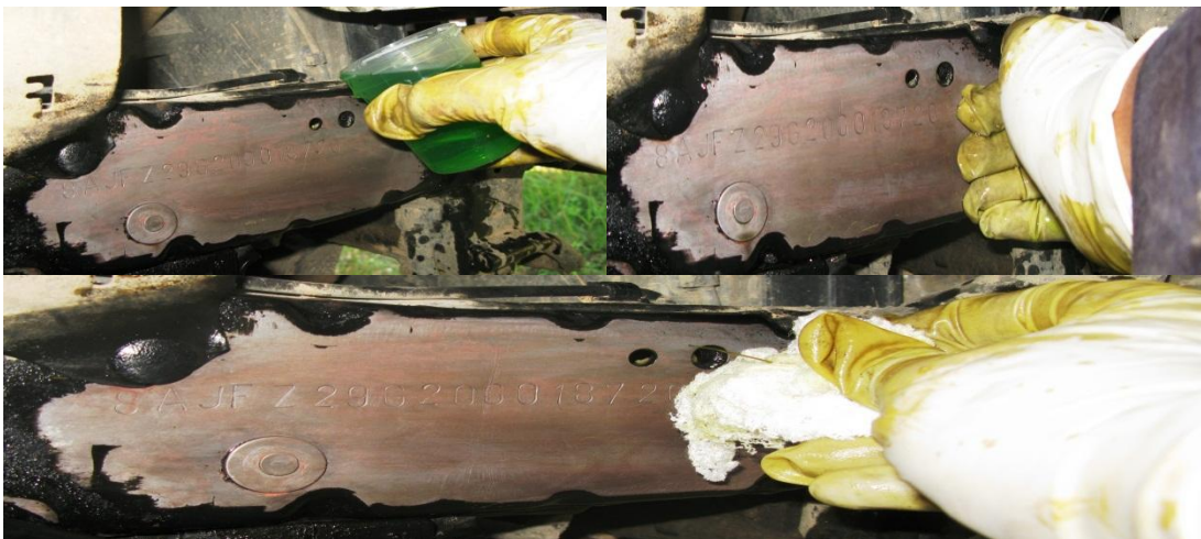
Figura 123. Lavado de área trabajada
