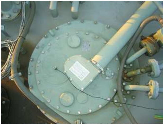
Figura 59. Cabeza del cambiador de derivaciones bajo carga
