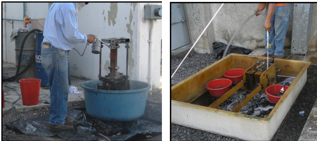
Figura 102. Lavado a presión del conmutador
