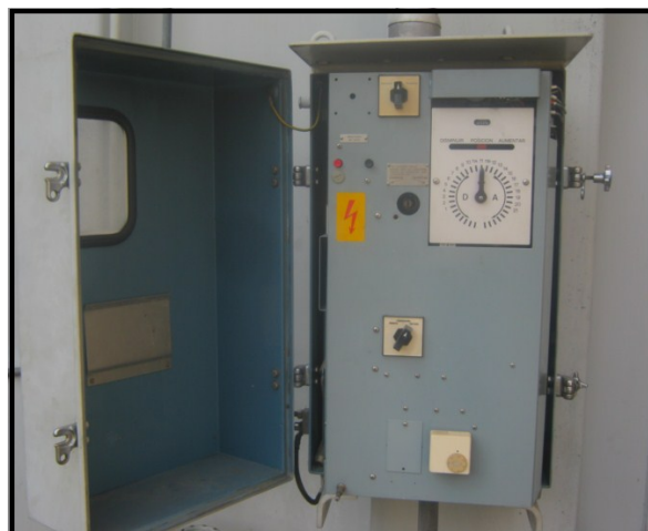
Figura 57. Accionamiento a motor de OLTC marca ABB
