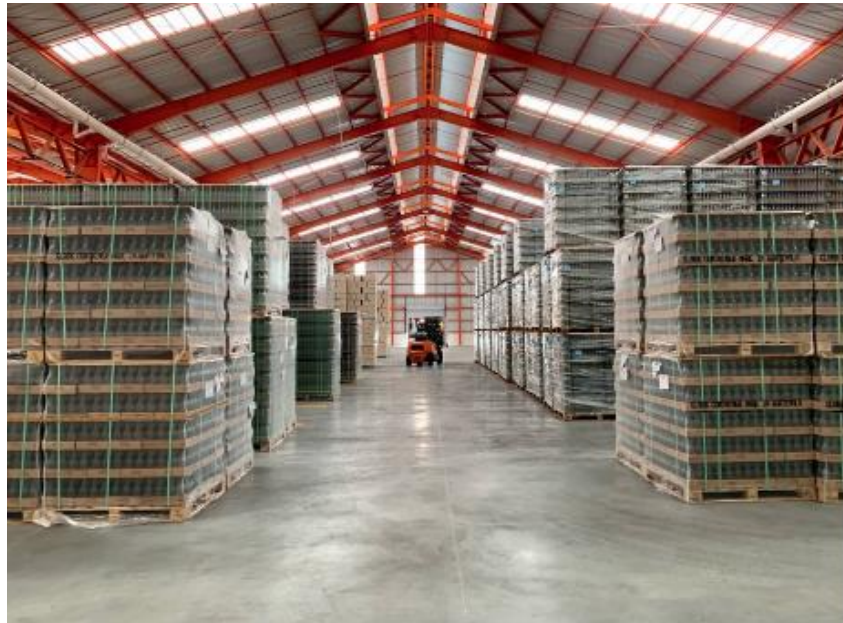
Figura 21. Bodegas de producto terminado
