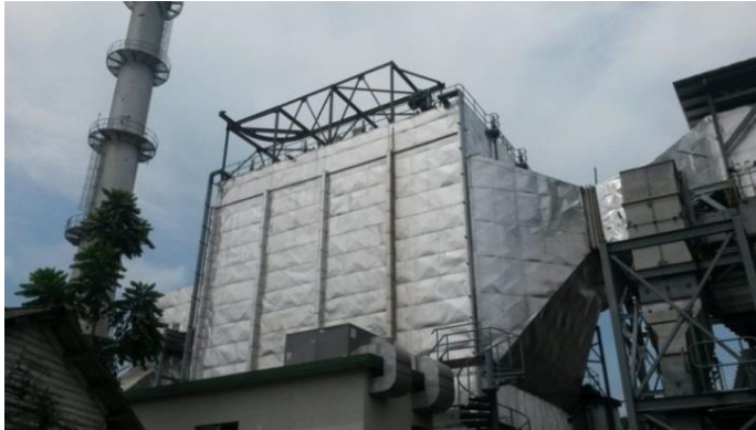
Figura 4. Precipitador electrostático (esp)
