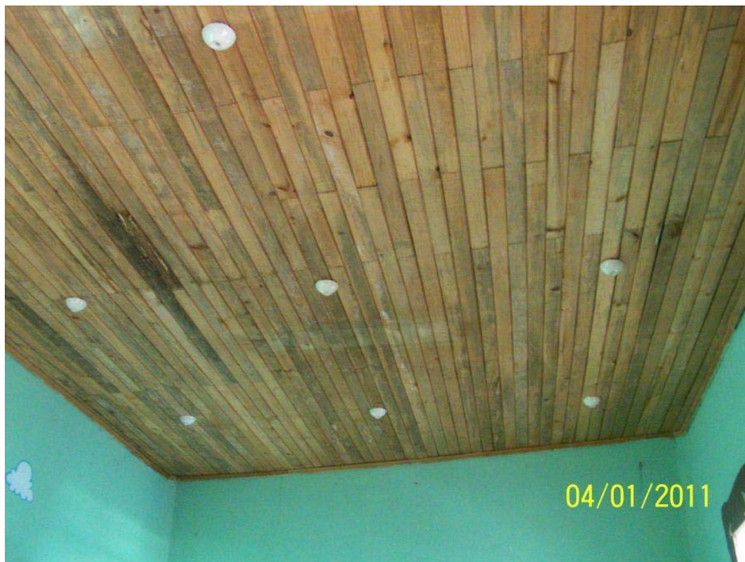
Figura 49. Plafoneras instaladas y cableadas
