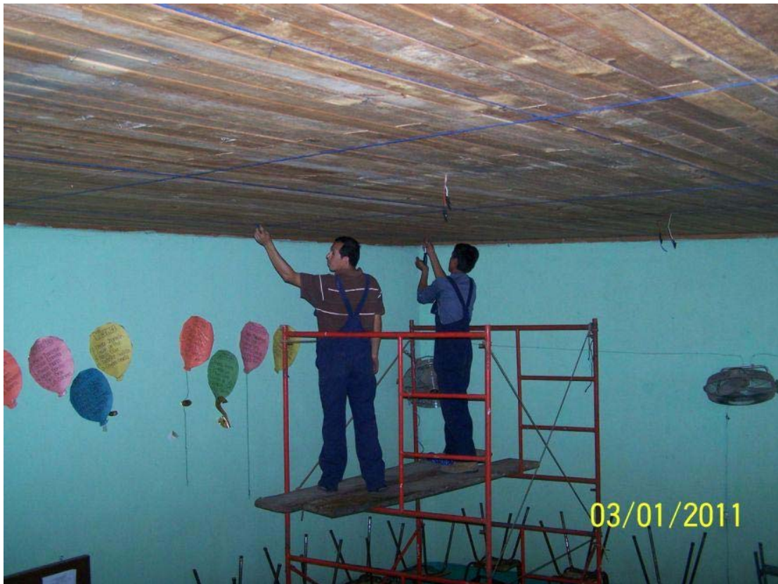
Figura 34. Marcaje de las plafoneras
