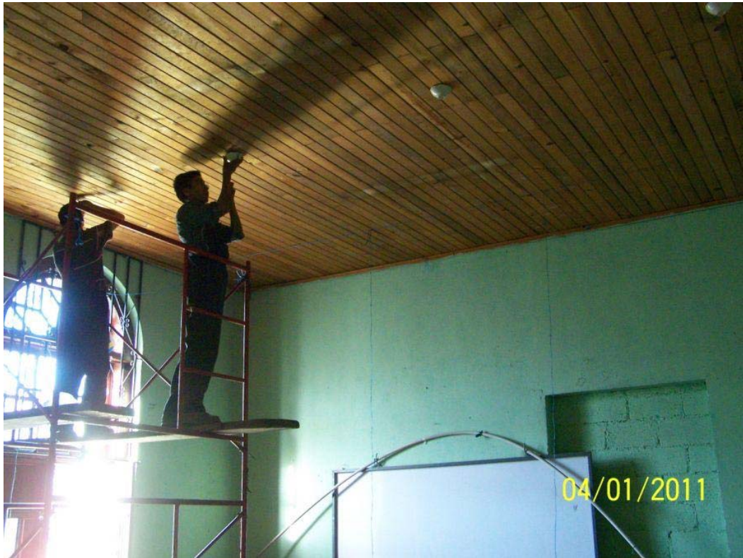
Figura 35. Instalación de plafoneras
