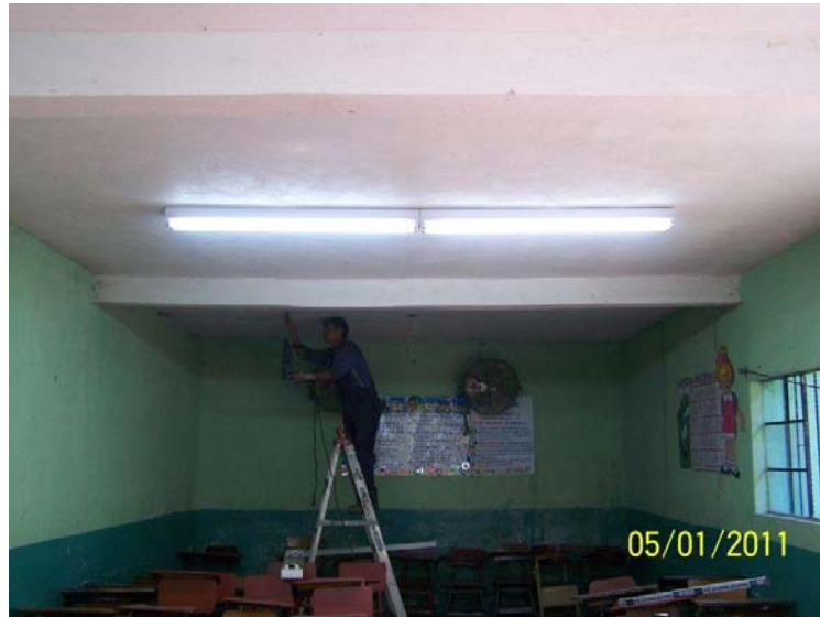
Figura 59. Instalación de luminarias reparadas
