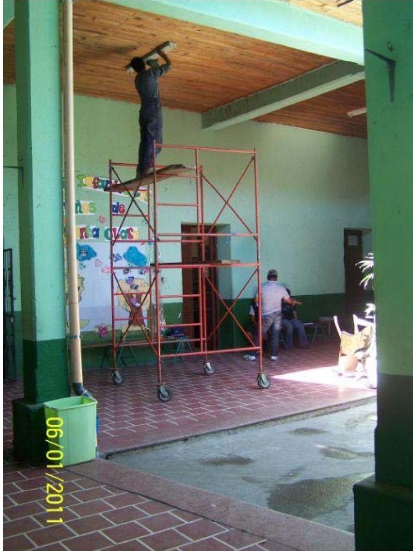
Figura 67. Remodelación en pasillos
