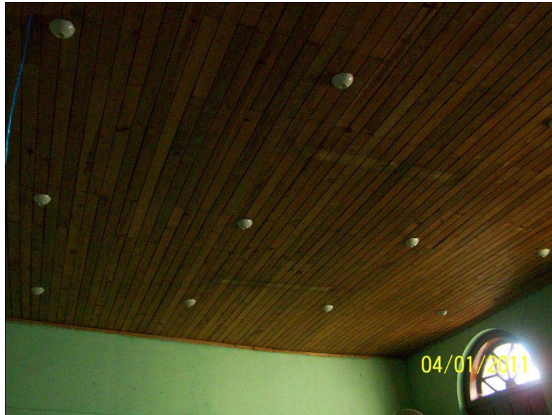
Figura 36. Vista final de las plafoneras instaladas
