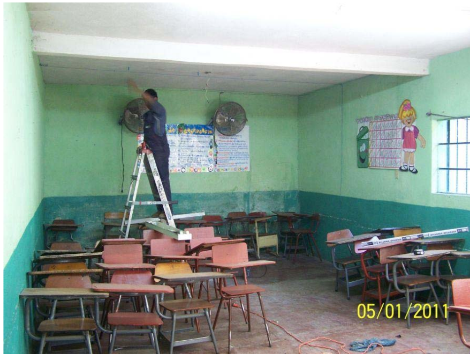
Figura 58. Instalación de luminarias reparadas
