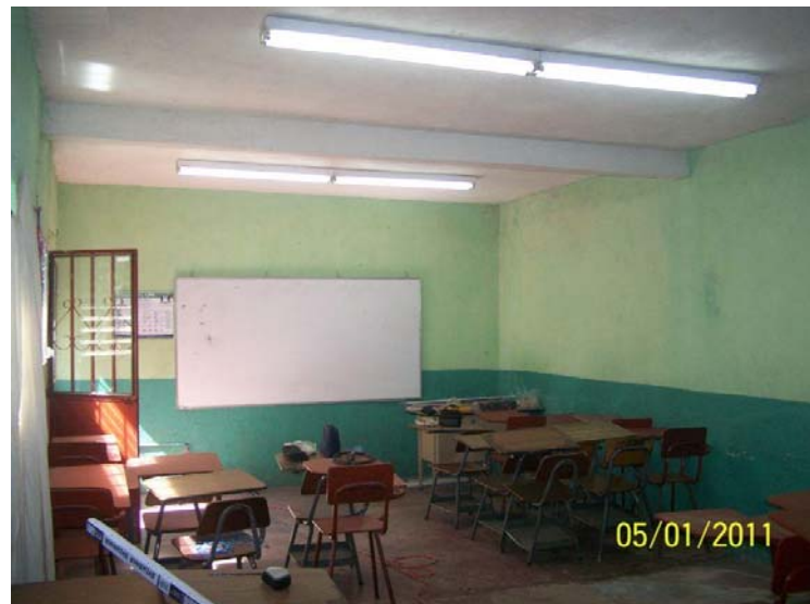
Figura 60. Instalación terminada, vista desde el fondo del salón
