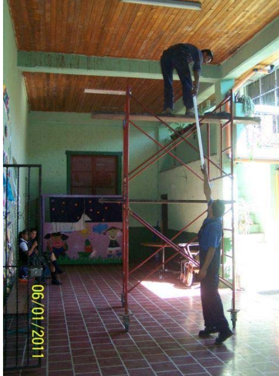
Figura 66. Remodelación en pasillos
