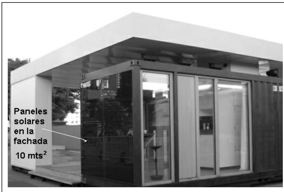
Figura 7. Distribución de los paneles solares en la fachada del prototipo
