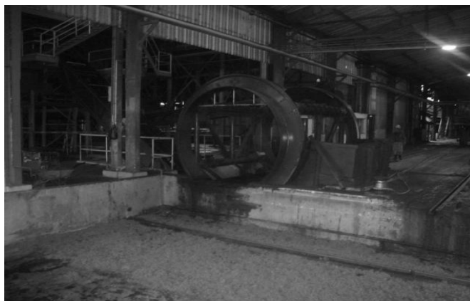
Figura 6. Área de volteo
