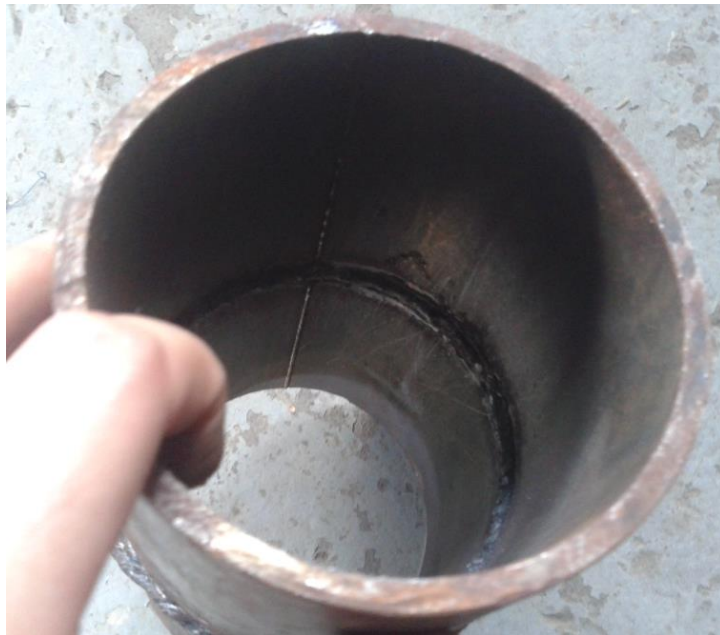
Figura 19. Soldadura en tubo fijo en posición horizontal, cordón de penetración o de raíz
