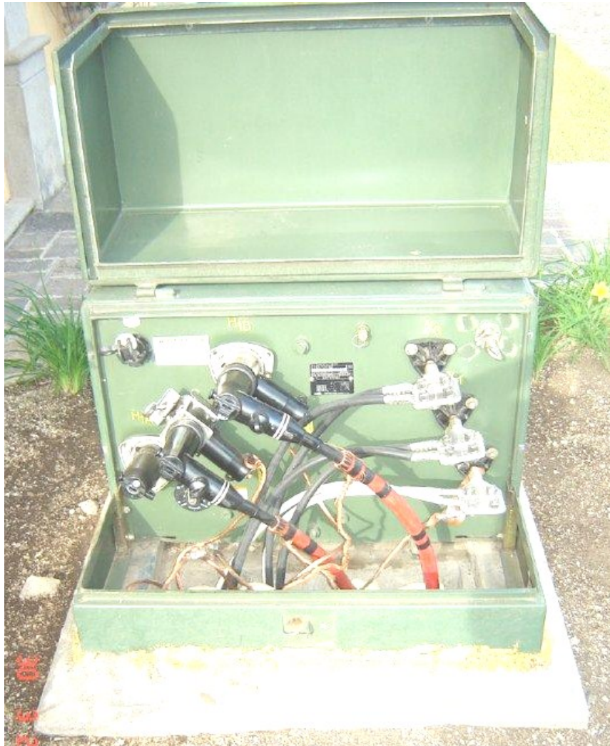
Figura 30. Transformador montado y conectado
