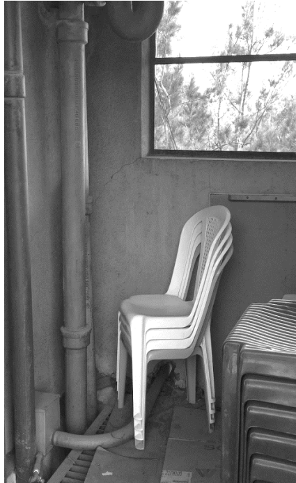
Figura 32. Ducto Eléctrico T-3
