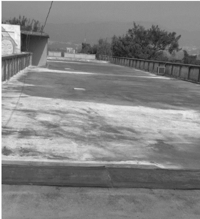
Figura 30. Vista de azotea A-A, del eje 5 al 1, edificio T-3
