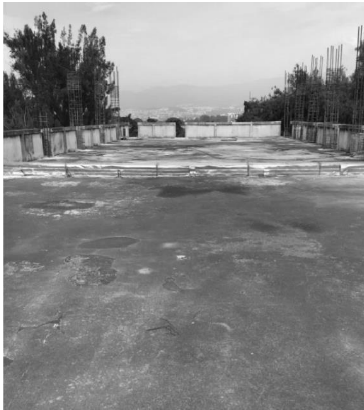
Figura 8. Azotea del edificio T-3
