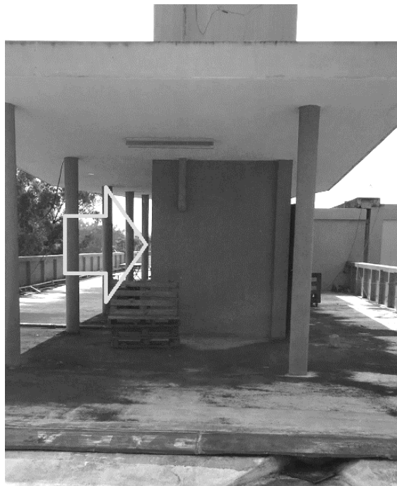
Figura 10. Área disponible para instalación de inversores
