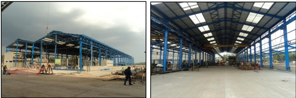
Figura 34. Construcción de la planta de malla electrosoldada
