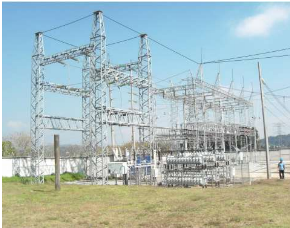
Figura 23. Hilo de guarda en la cima de las torres, lado de 69 kV
