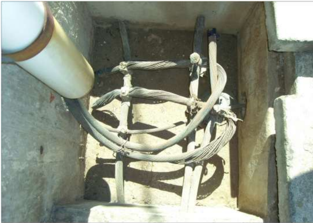
Figura 14. Soldadura exotérmica de una red de tierra
