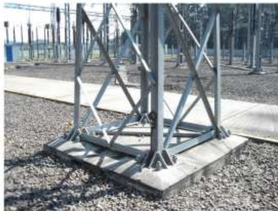
Conexión a estructura de acero angular
