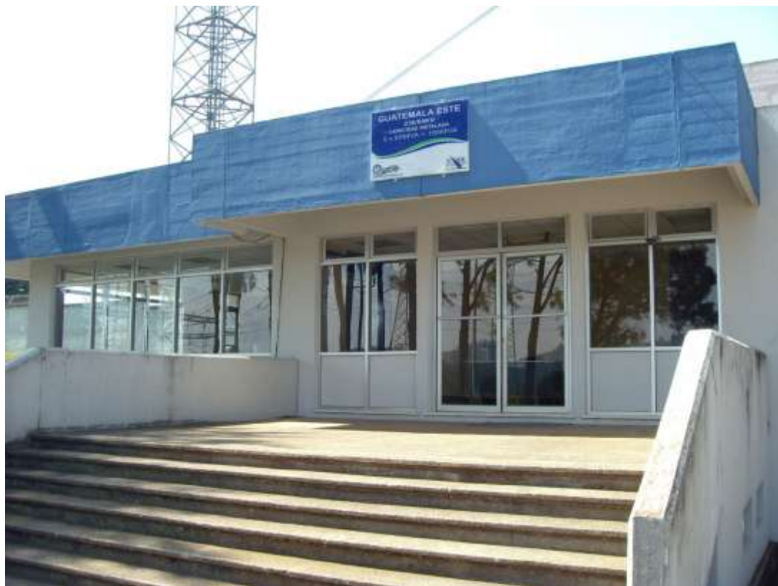
Figura 46. Oficina de monitoreo de la subestación Guatemala Este
