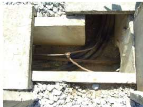
Canaleta de concreto
