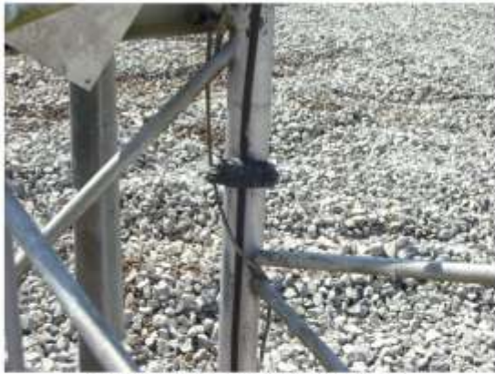
Conexión a una estructura de acero circular
