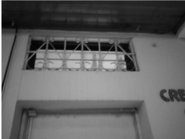
Figura 25. Espacio dispuesto para la instalación del evaporador 1
