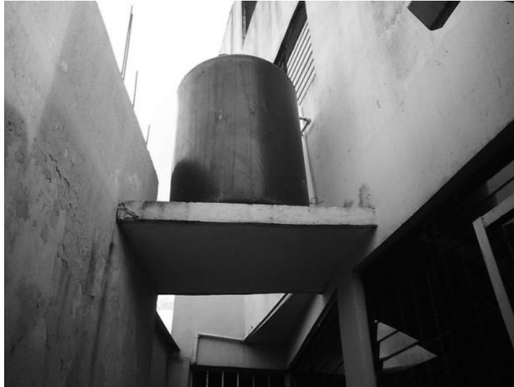
Figura 27. Espacio dispuesto para instalación de condensador 1
