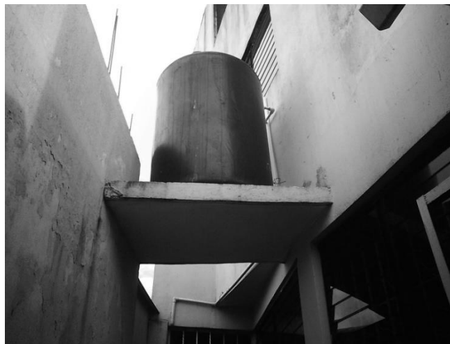
Figura 19. Terraza de concreto
