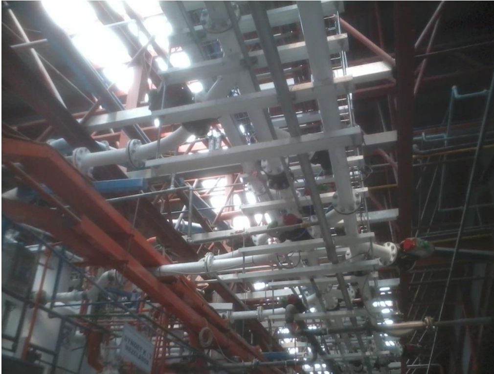
Figura 23. Cargadores de tubería
