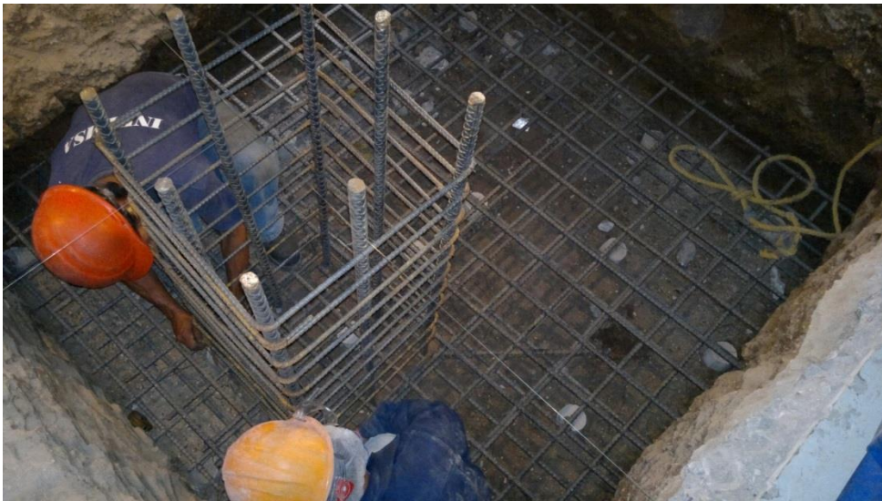
Figura 3. Estructura de zapata
