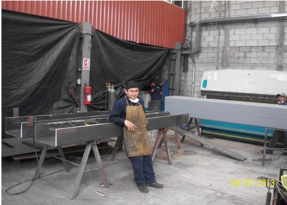
Figura 8. Fabricación de columnas
