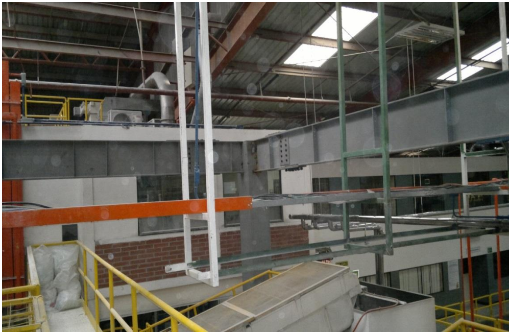
Figura 13. Instalación de vigas
