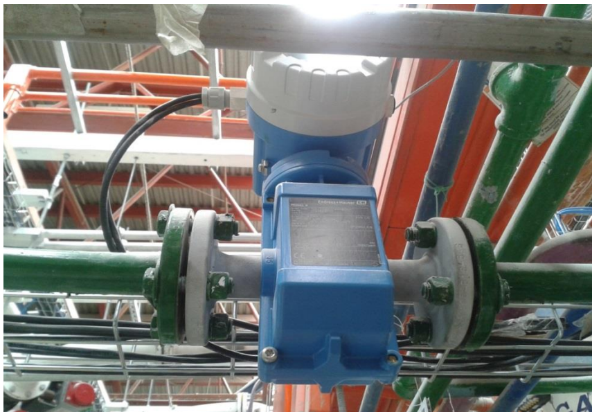
Figura 27. Medidor de flujo magnético
