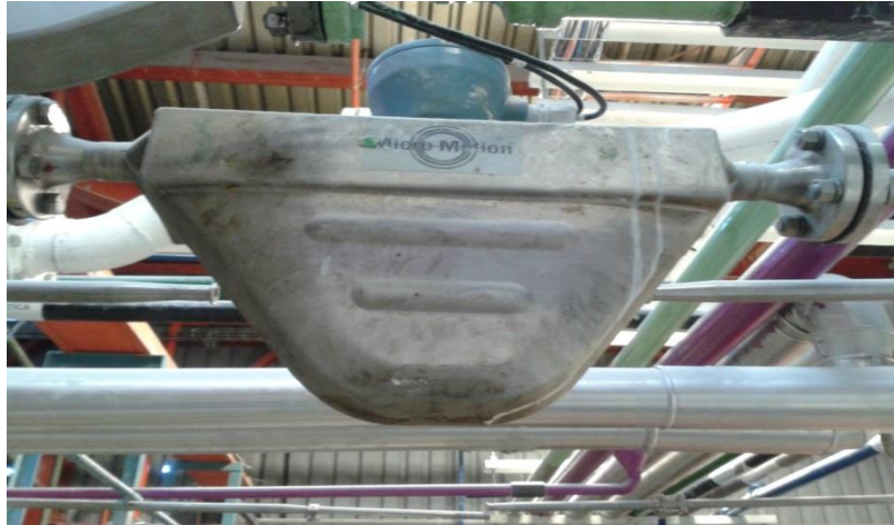
Figura 26. Medidor de flujo Coriolis
