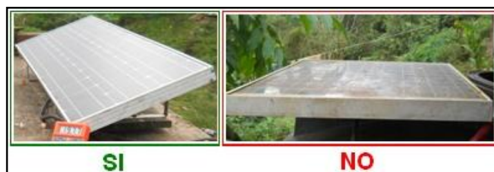
Figura 16. Instalación correcta e incorrecta de los paneles
