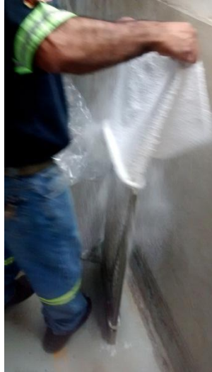
Figura 70. Suciedad en los filtros
