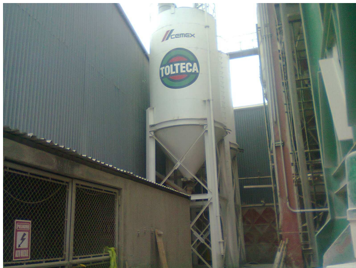
Figura 11. Instalaciones del área de recepción (MASA)
