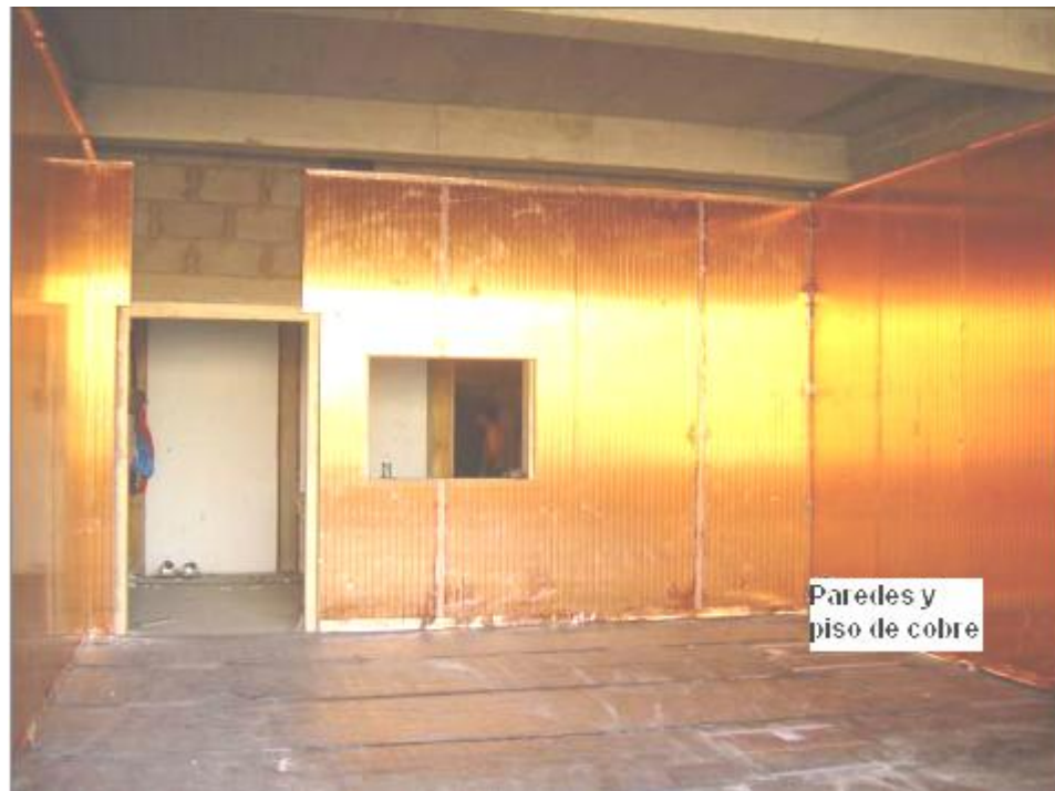
Figura 42. Jaula de Faraday en proceso de construcción
