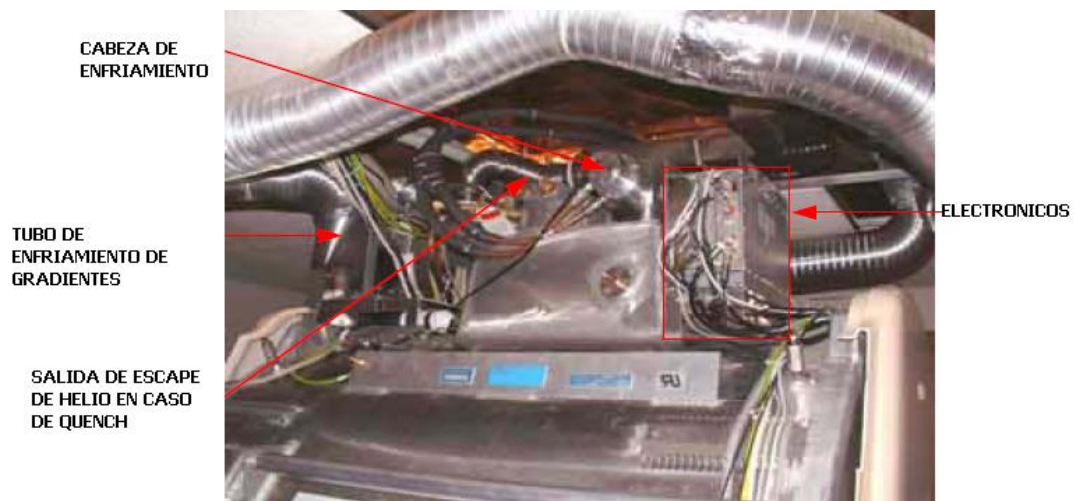
Figura 47. Localización de la cabeza de enfriamiento arriba del magneto
