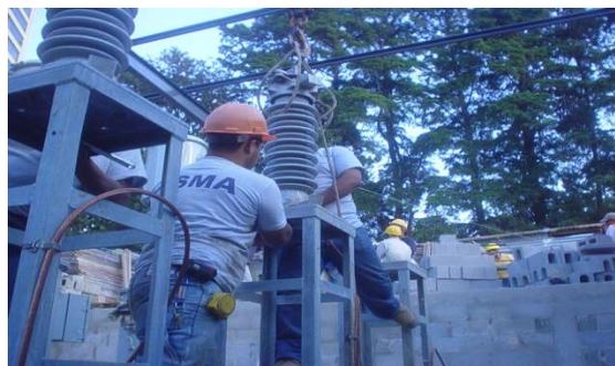
Figura 23. Instalación de apartarrayos
