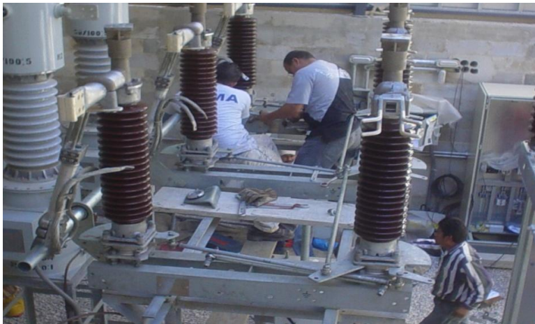
Figura 25. Instalación de las cuchillas seccionadoras
