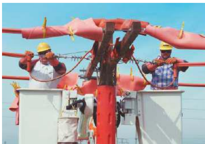
Figura 33. Equipo de protección al trabajar en líneas vivas
