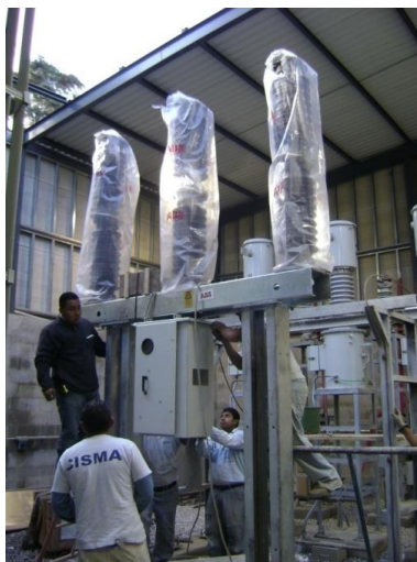
Figura 24. Colocación del interruptor de potencia SF6
