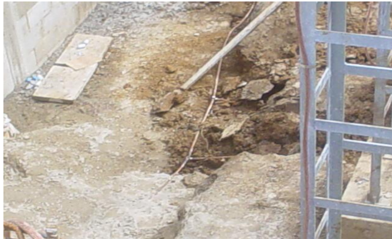
Figura 18. Red de tierras centro comercial Oakland Mall
