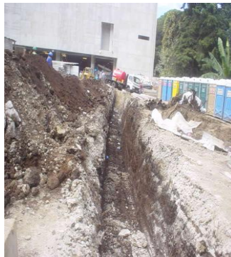
Figura 19. Zanja colocación de tubería que alimentará la subestación
