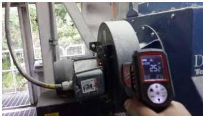
Figura 19. Inspección de medición de temperatura
