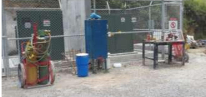
Figura 12. Taller de mantenimiento
