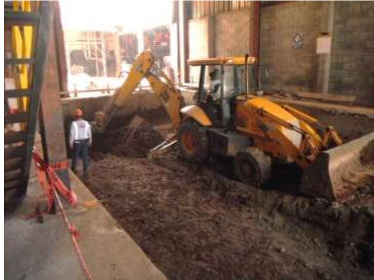
Figura 3. Excavación del terreno
