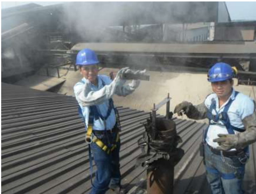
Figura 27. Cambio del testigo en la tubería de soplado
