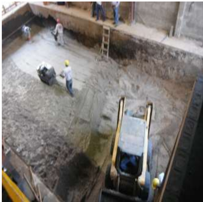
Figura 5. Compactado del selecto y nivelación
