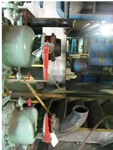
Figura 21. Fabricación de la tubería de agua de enfriamiento
