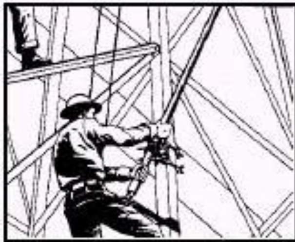
Figura 15. Instalación de los bastones elevadores a la silleta
