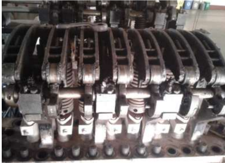
Figura 7. Válvula de control de vapor
