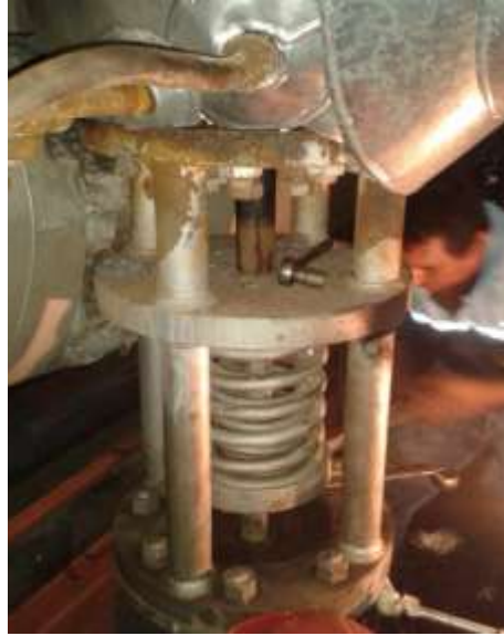
Figura 27. Válvula de cierre rápido
