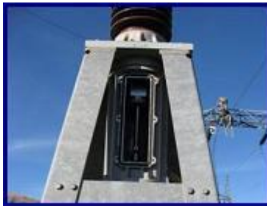
Figura 44. Interruptor con mando hidráulico con desplazamiento lineal CB FX-170 Alstom
