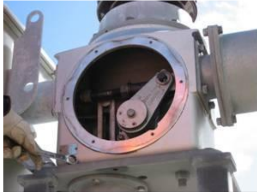
Figura 43. Mecanismo de operación con desplazamiento angular (90° nominal CB HPL245 ABB)
