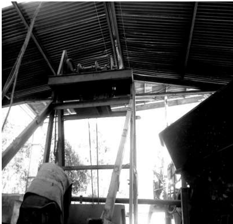
Figura 37. Montaje de skip
