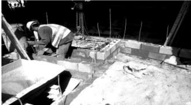
Figura 32. Paredes de fosa II
