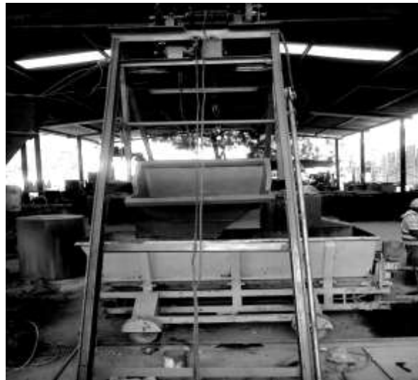
Figura 41. Skip y guías instaladas
