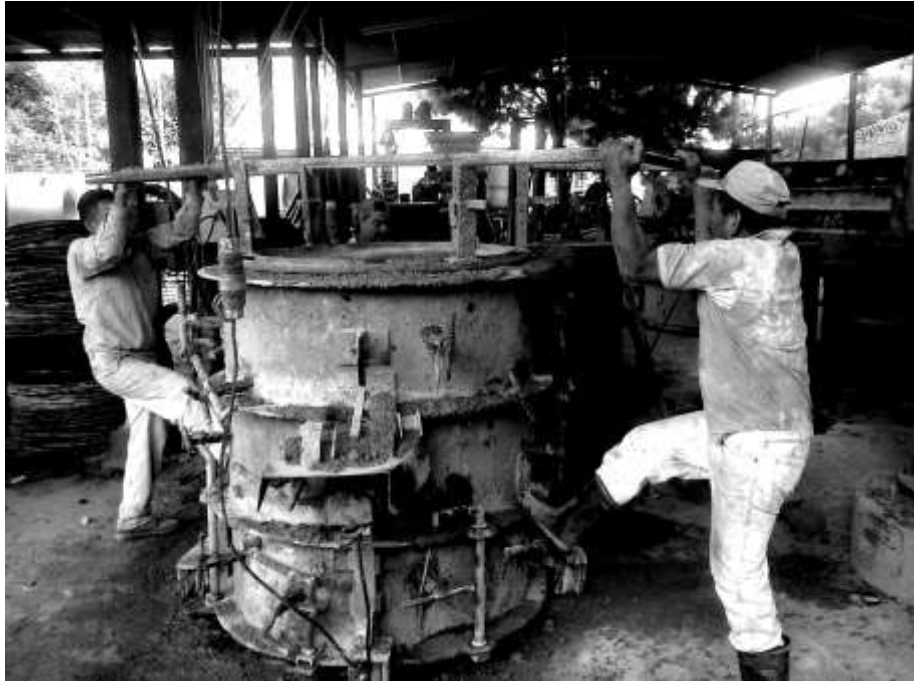
Figura 21. Proceso de llenado y vibrado de molde
