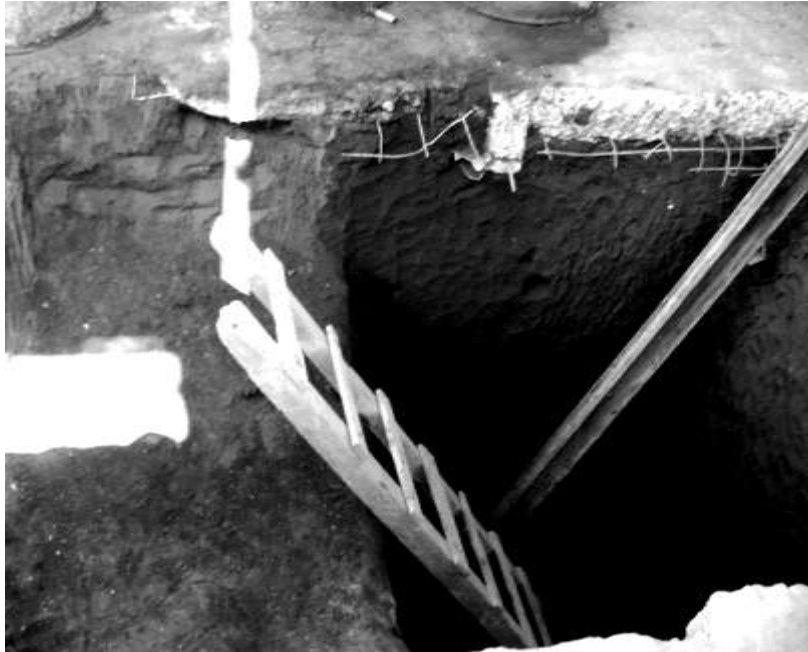
Figura 30. Fosa para mezcladora
