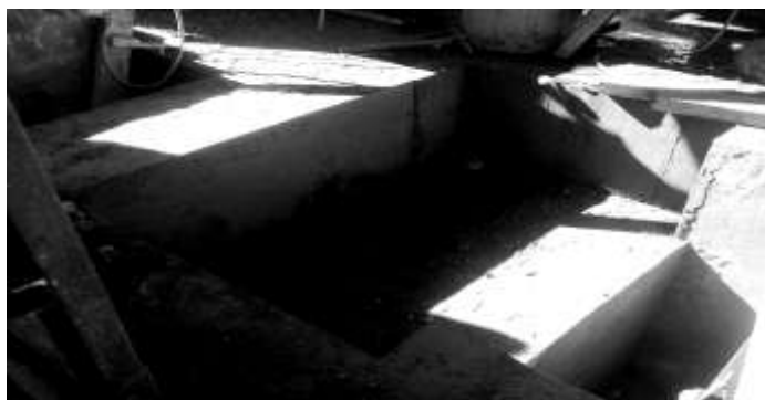
Figura 33. Fundición de cimiento
