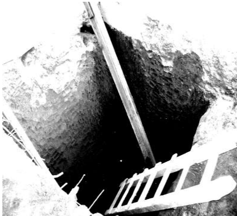
Figura 29. Fosa para cimentación de skip
