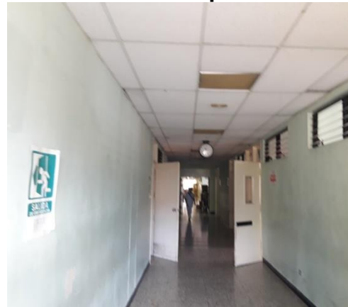
Muros de mampostería
