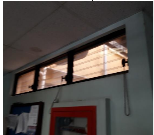
Muros de mampostería
