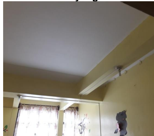
Losas y vigas
