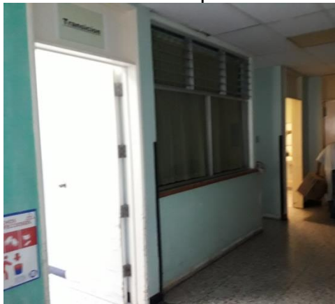
Muros de mampostería
