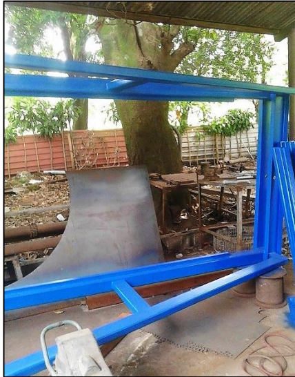
Figura 29. Estructura de sistema de elevación
