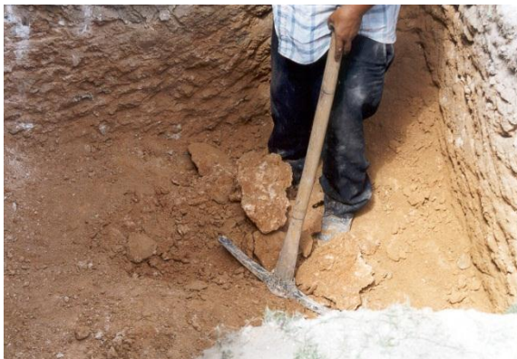
Figura 45. Foso para electrodo a) Excavación b) Acabado
