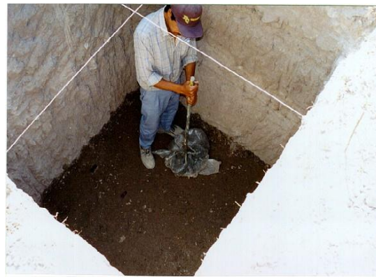
Figura 45. Foso para electrodo a) Excavación b) Acabado
