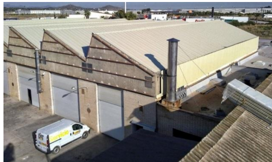
Figura 44. Techo dientes de sierra
