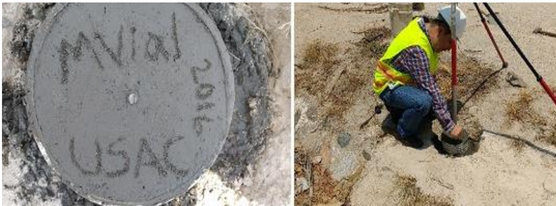
Figura 5. Monumentación del punto de inicio
