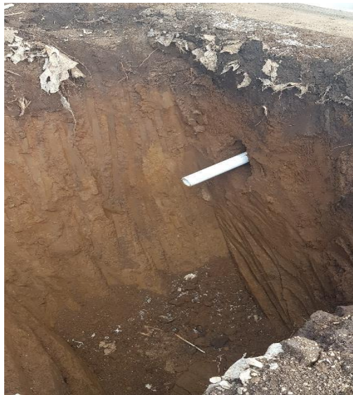
Figura 18. Suelos alta permeabilidad en excavación 4 m para PTAR
