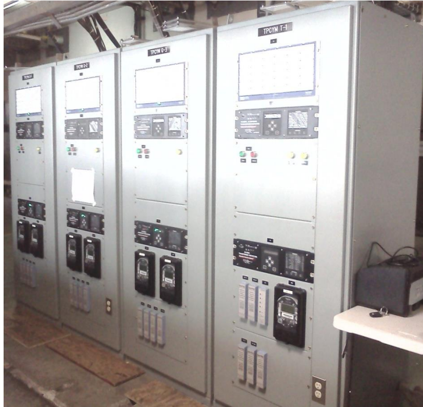
Figura 26. Vista lateral final de las protecciones
