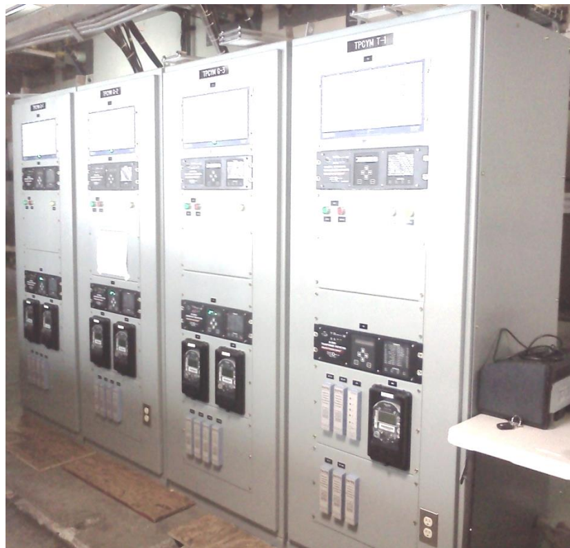
Figura 14. Vista lateral final de los tableros de protecciones
