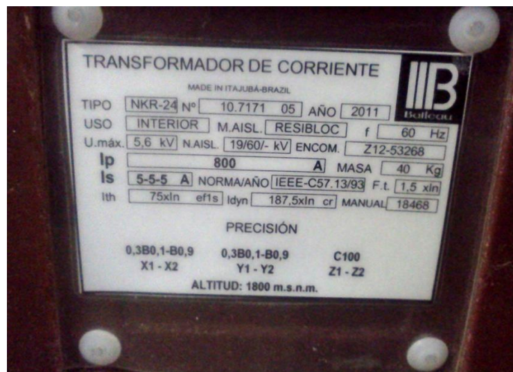
Figura 5. Datos de placa, CT's de salida de la unidad 3
