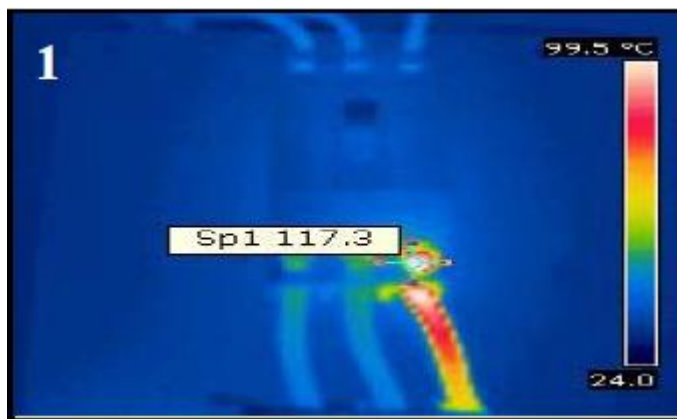
Figura 36. Ejemplo de termograma
