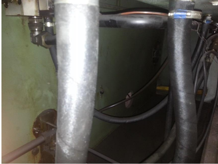
Figura 40. Mangueras de hidráulico
