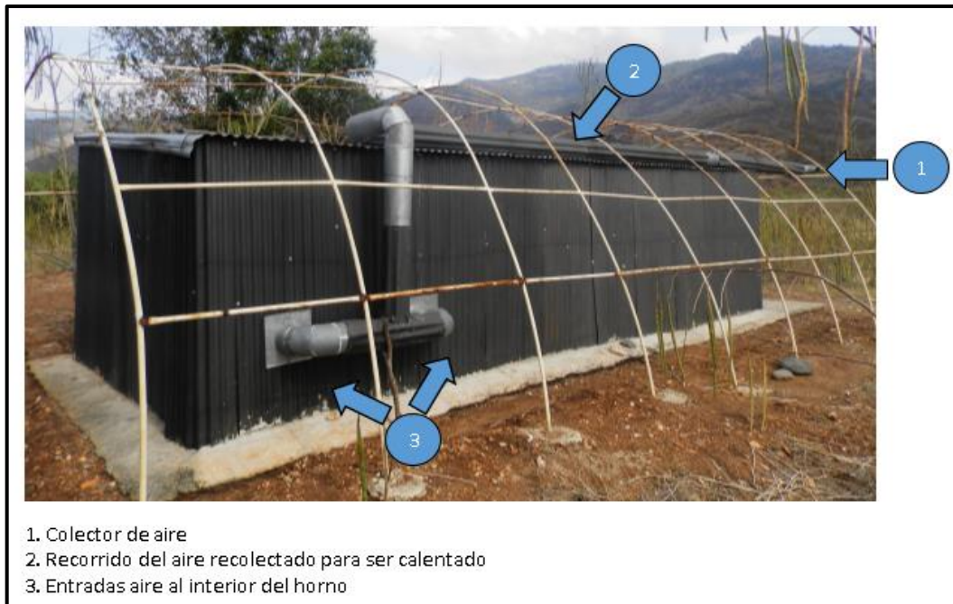
Figura 10. Tubería del horno actual de secado
