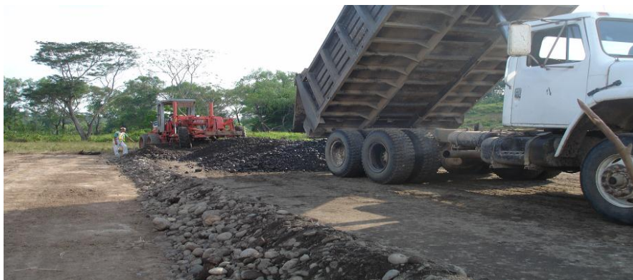
Figura 17. Tendido del material con motoniveladora
