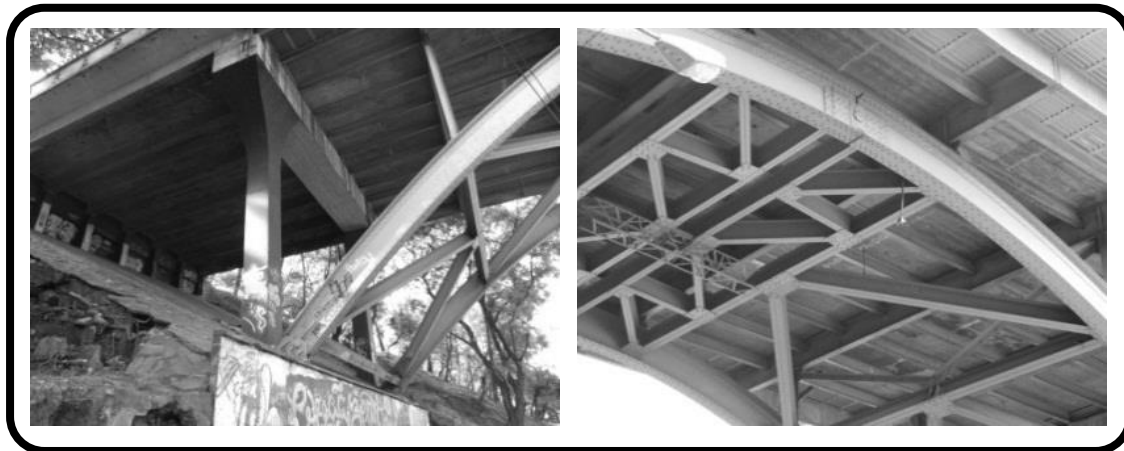
Figura 4. Estado actual de puente arco triarticulado de acero estructural del puente olímpico con tablero superior en Guatemala
