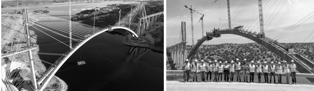
b) Viaducto Ferroviario de Almonte, Madrid-Frontera Portuguesa (27/10/2015)
