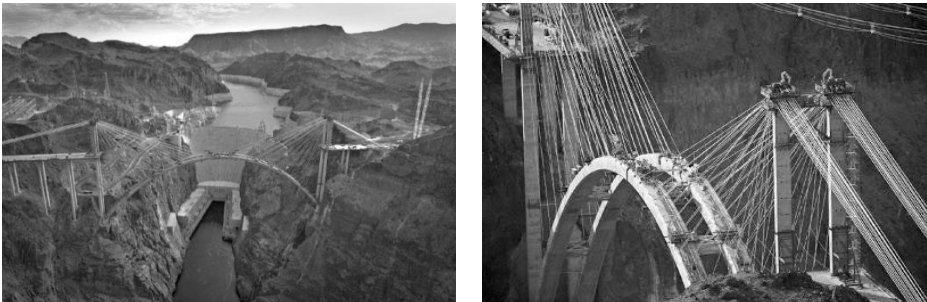
a) Puente Hoover Dam sobre el río Colorado, USA (2010) L=318\text{m}
