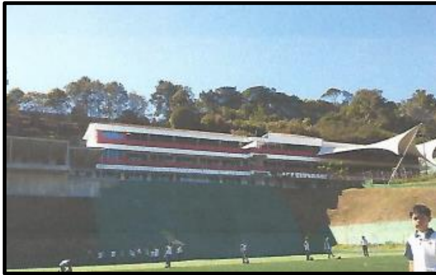
Figura 5. Fotografía edificio actual
