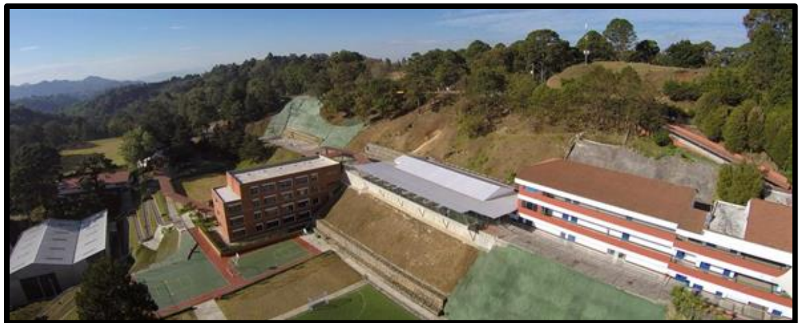
Figura 8. Vista aérea conjunto, centro escolar Solalto
