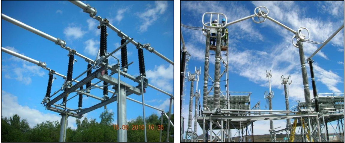
Figura 11. Seccionadores verticales
