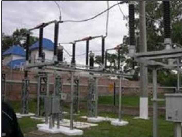
Figura 10. Seccionador horizontal invertido
