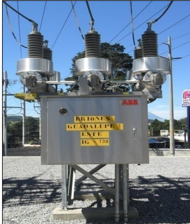
Figura 13. Interruptor de potencia
