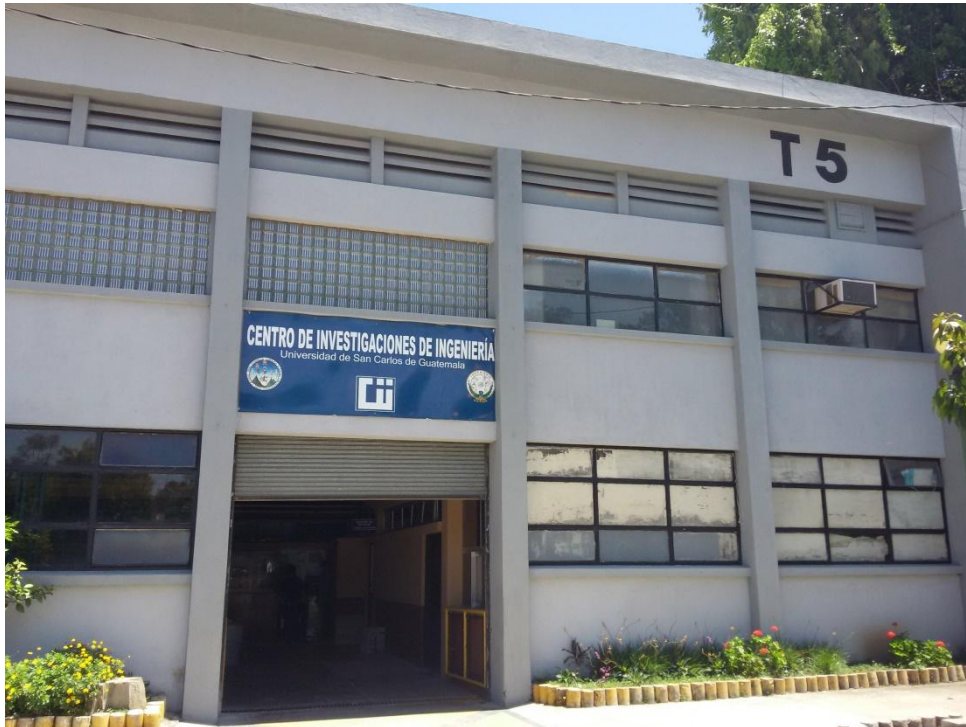
Figura 1. Edificio del Centro de Investigaciones de Ingeniería
