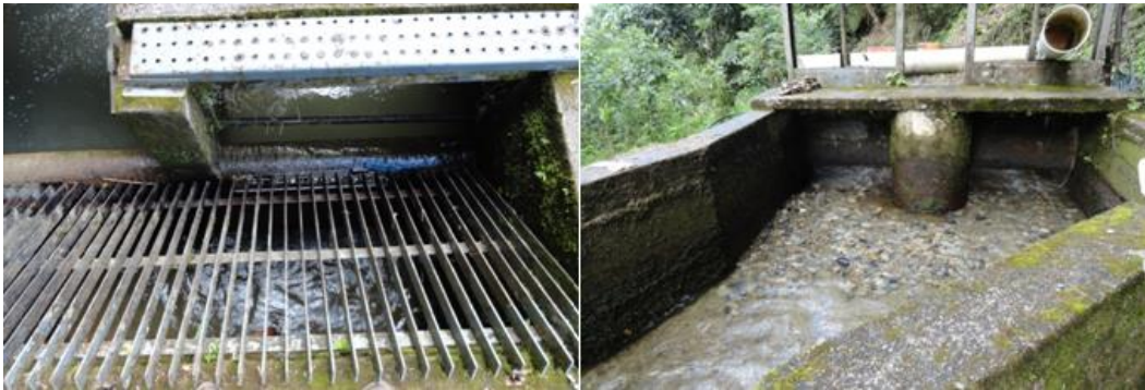
Figura 3. Desarenador y cámara de carga
