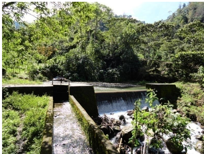
Figura 2. Sistema de aducción
