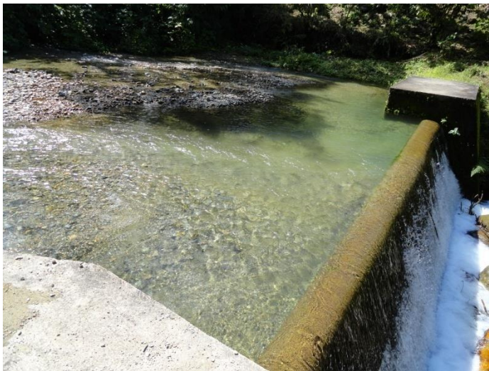
Figura 1. Obra de toma
