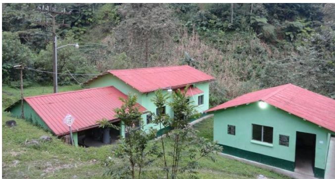
Figura 6. Casa de máquinas
