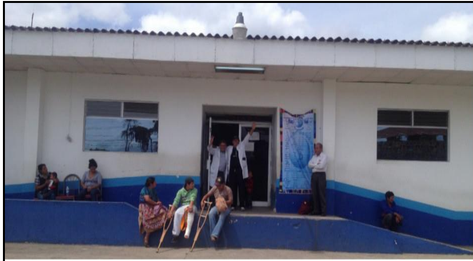
Figura 7. Vista exterior de Hospital Nacional de Chimaltenango
