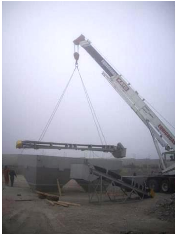
Figura 29. Montaje mecánico, mediante grúa
