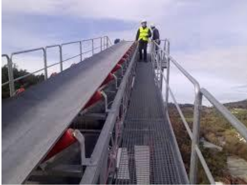
Figura 30. Accesos para mantenimiento
