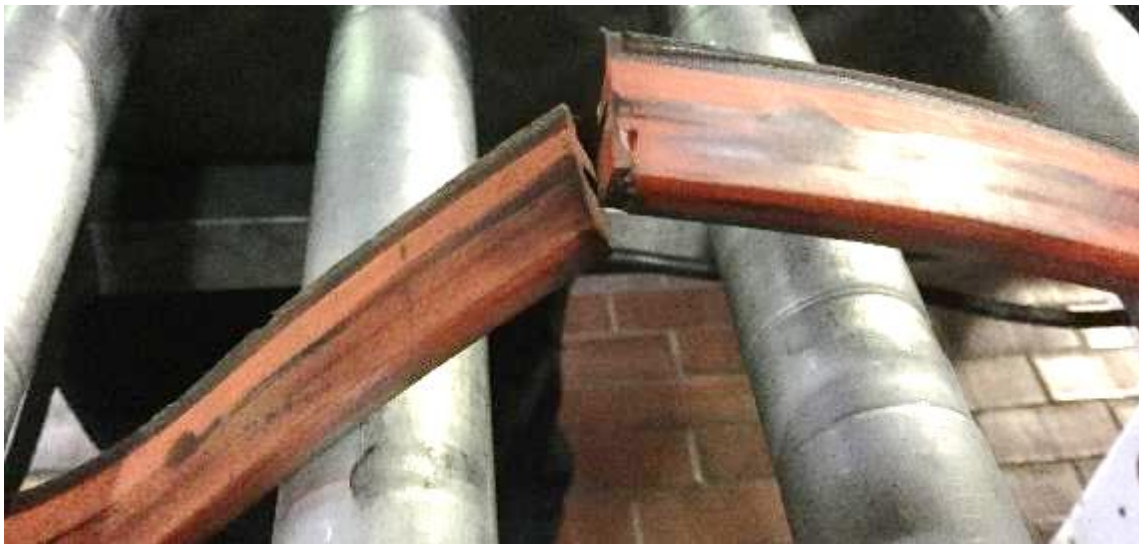
Figura 20. Rotura por atasco de faja de polea central
