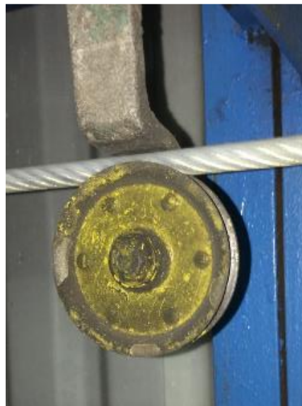
Figura 12. Polea con desgaste en rodamiento
