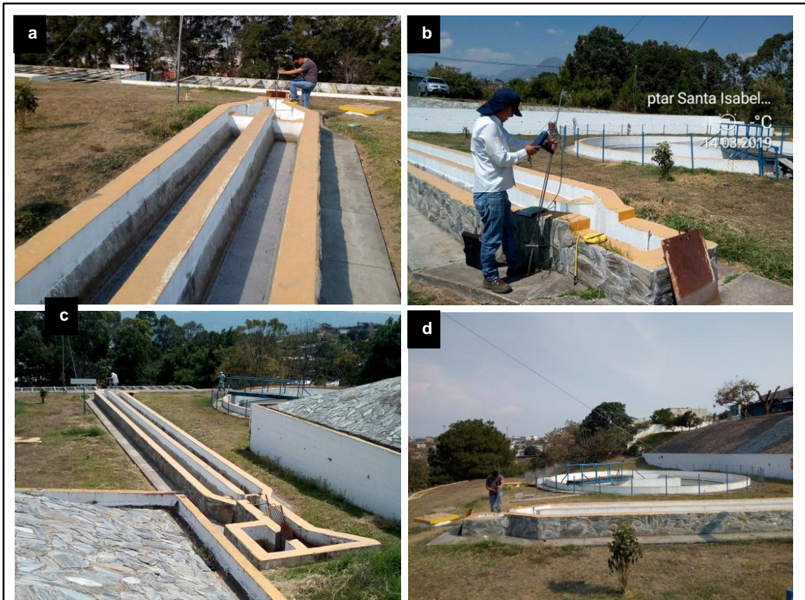
Fotografías tomadas en la planta de tratamiento Santa Isabel II.
