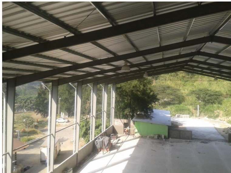
Figura 10. Área de construcción de caldera de biomasa
