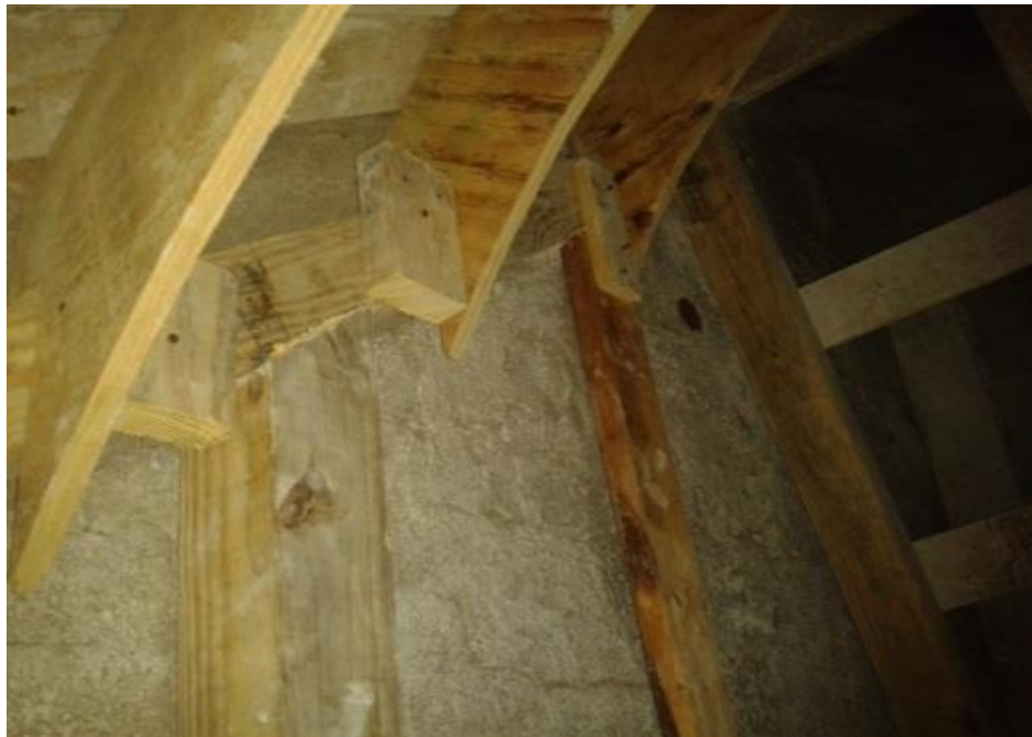
Figura 17. Construcción lateral de la cámara de combustión
