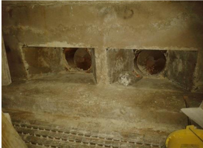
Figura 18. Construcción del área de alimentación de combustible
