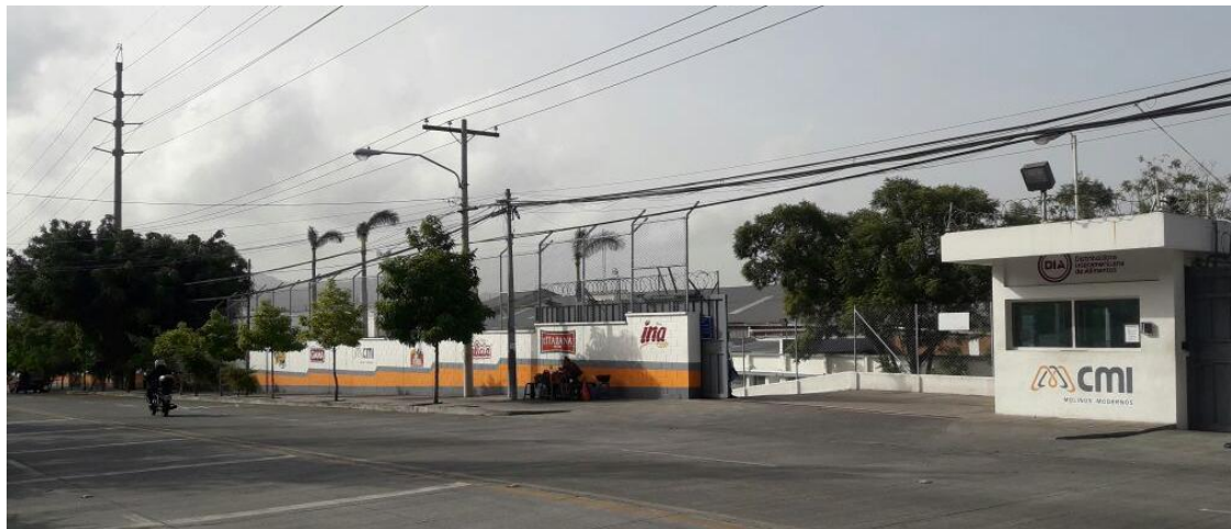
Figura 26. Centro de distribución, 50 calle, avenida Petapa zona 12
