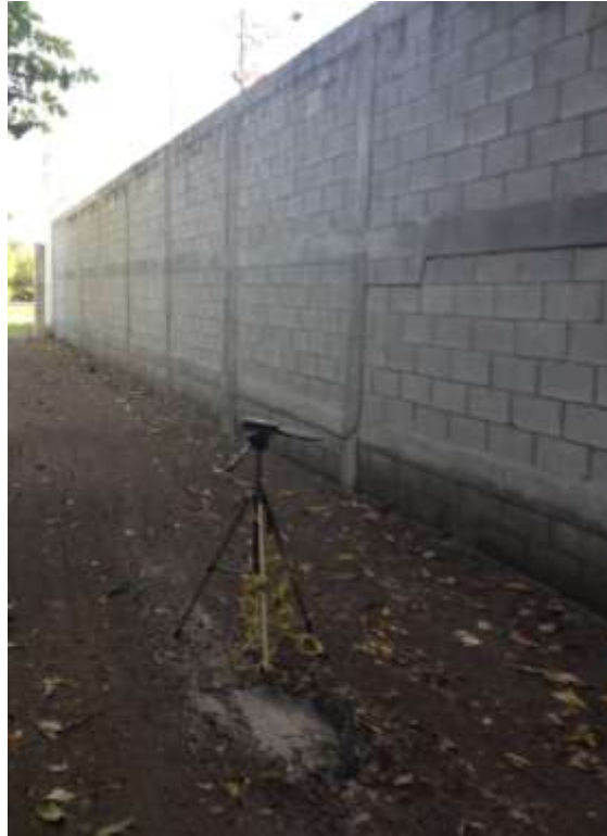
Figura 15. Medición campo eléctrico colindancia 3 subestación El Milagro
