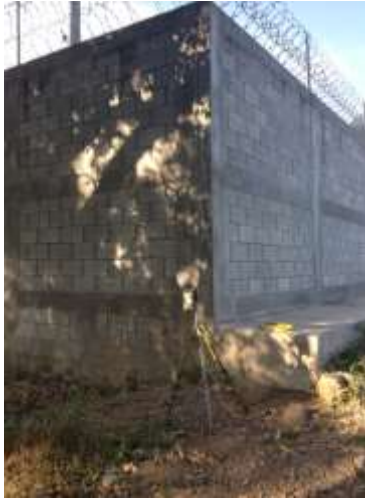
Figura 13. Medición campo magnético colindancia 1 subestación El Milagro
