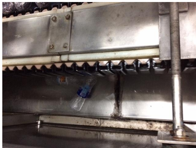
Figura 14. Pérdida de materia prima en los equipos
