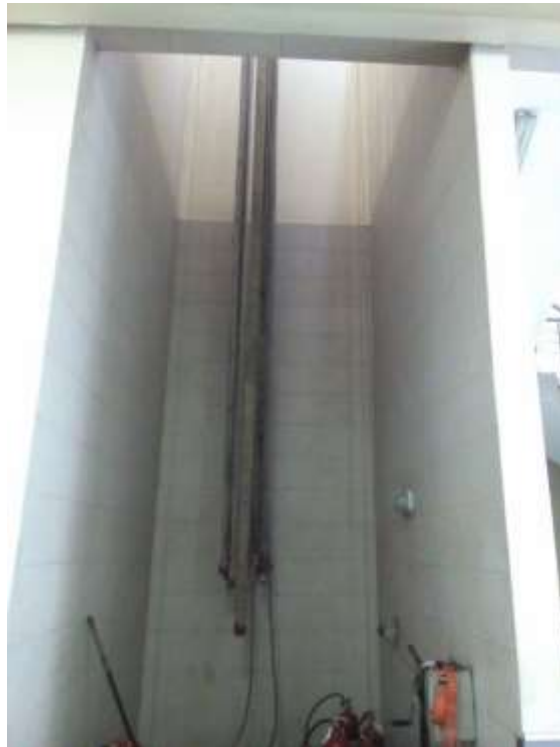
Figura 41. Tendedero de mangueras de estación dos
